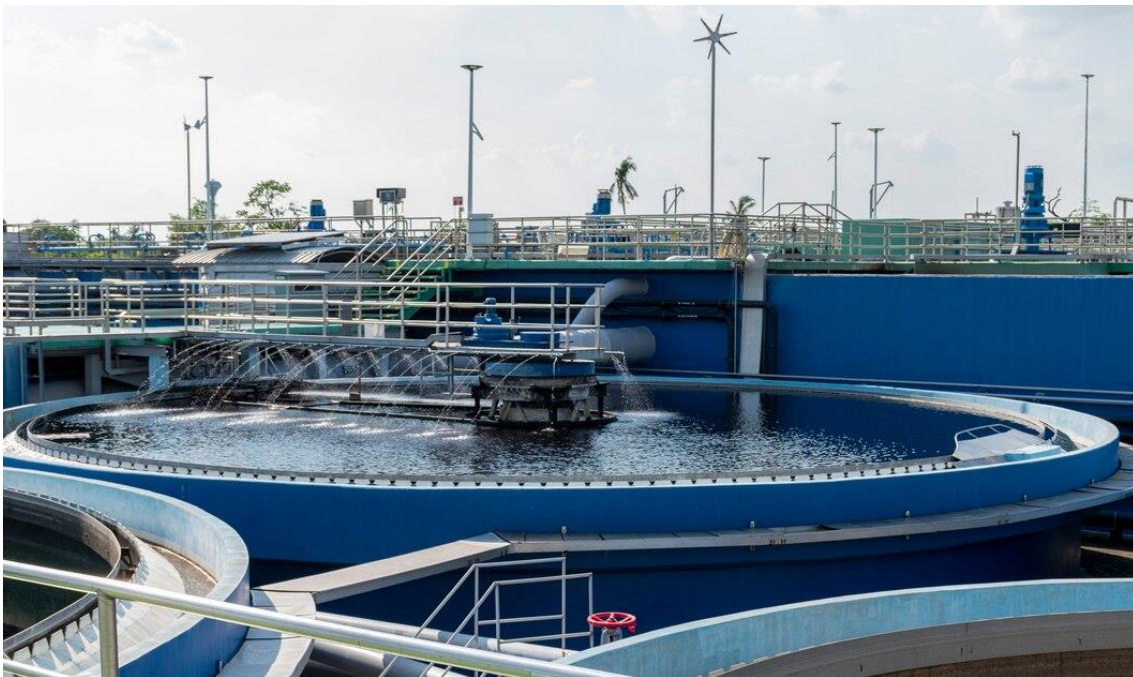
Foto de estanques para el tratamiento de aguas residuales en un polígono industrial. Crédito: Freepik.
